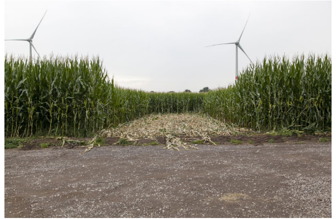
WEA 6 Ausbuchtung für Großkran
