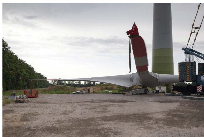
WEA 9 Die Rotorblätter wurden vormontiert
