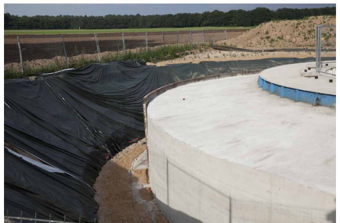
WEA4 / Betoniertes Fundament, teilweise noch verschalt
