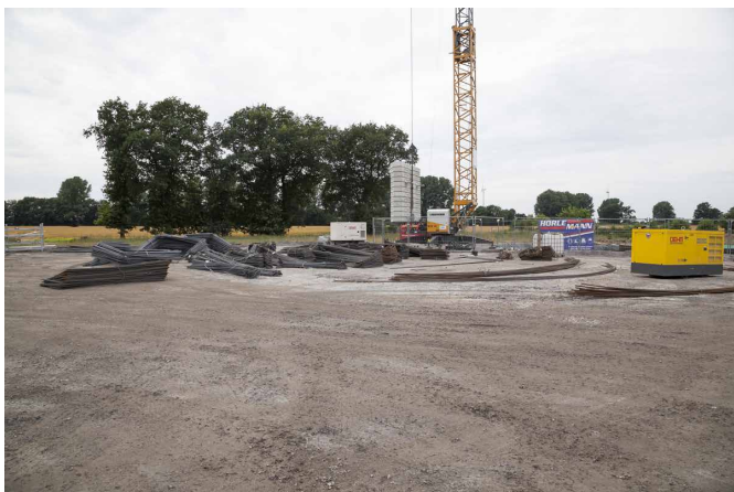
WEA2 / Kranstellfläche mit Stahl und Fertigschalelementen
