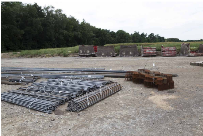
WEA1 / Stahl und Fertigschalung zur weiteren Verarbeitung
