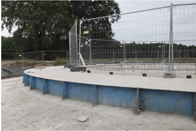
WEA4 / oberer Fundamentkranz
