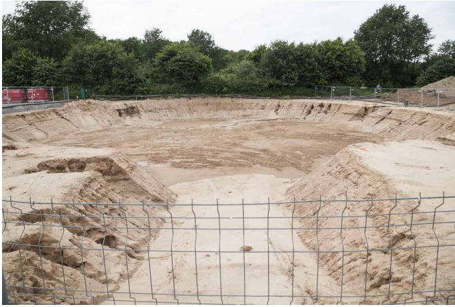
WEA3 / Erdarbeiten zur Vorbereitung der Sauberkeitsschicht
