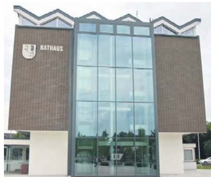
Das neue „Gesicht“ des Weezer Rathauses. Die vorgesetzte Glasfassade birgt den langersehten Aufzug und erlaubt einen Blick auf den Cyriakusplatz.
