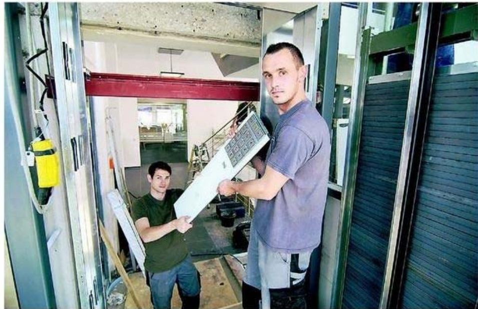
Bald müssen Bürger und Mitarbeiter im Rathaus Weeze nicht mehr zwingend die Treppe benutzen: Die Monteure Stefan Kummelat und Dennis Czernio montieren den neuen Aufzug. RP-FOTO: GERHARD SEYBERT
