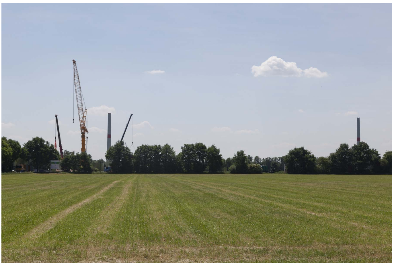
Kran an der WEA7, im Hintergrund die Türme der WEA 8 und 9
