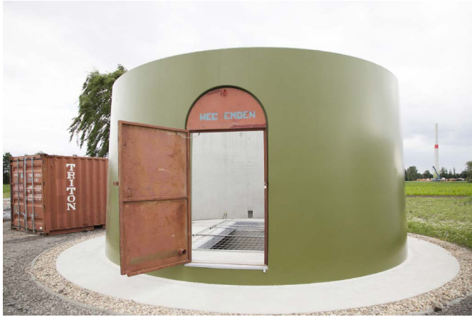
WEA 7 - Kellerdecke und erstes Turmsegment montiert
