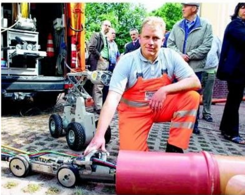
Mit solchen kleinen Kameras werden die Rohre inspiziert . Dafür ist die Erfahrung von Fachfirmen nötig. RP-ARCHIVFOTO: LAASER
