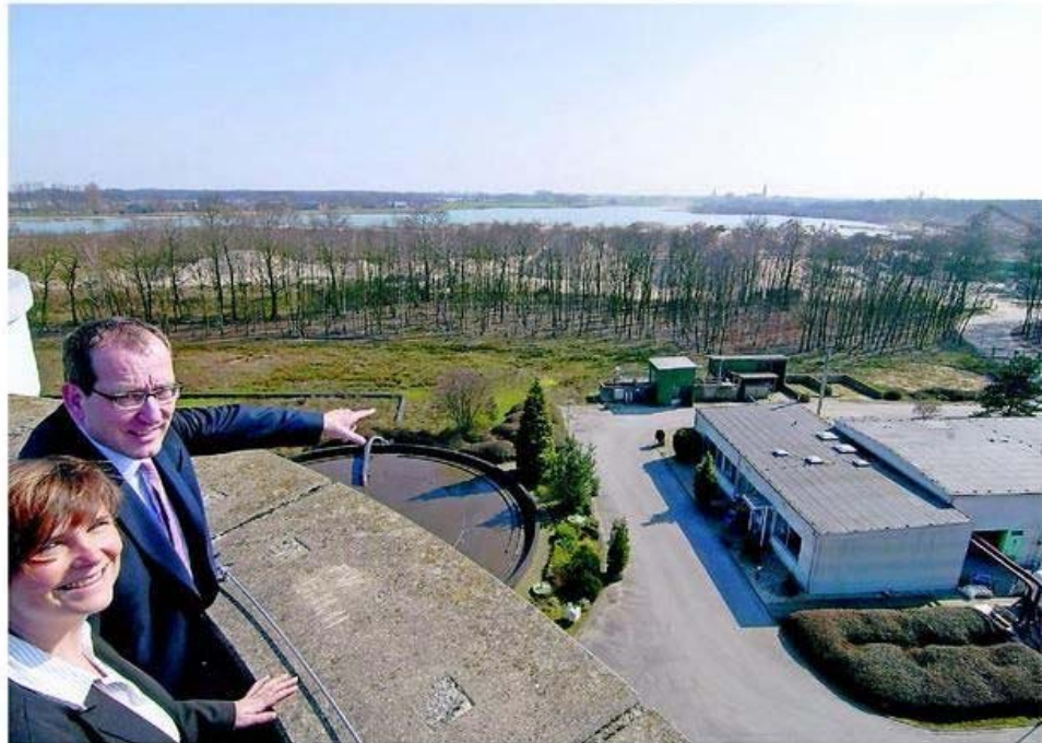
Margit Heinz, Pressesprecherin Niersverbandes, und Abteilungsleiter Ulrich Otto erklären die Erweiterungsfläche für die Kläranlage in Kevelaer-Hüdderath an der B 9. RP-FOTO: GERHARD SEYBERT
